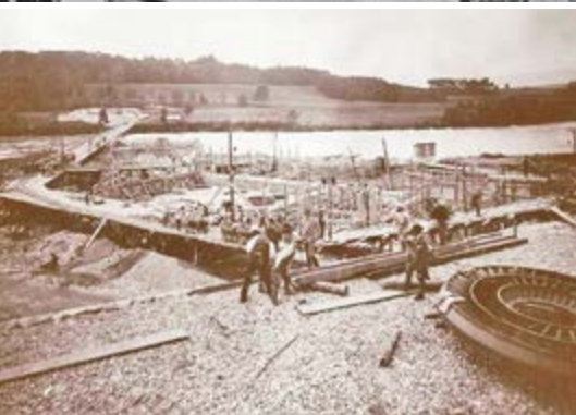
Mit dem Bau des Flusskraftwerks in Wynau wurde im Oberaargau innert weniger Jahre Strom für die Bevölkerung verfügbar. Rechts unten im Bild des Bauplatzes ist einer der fünf Generatoren zu sehen, die später installiert wurden (oberes Bild).
